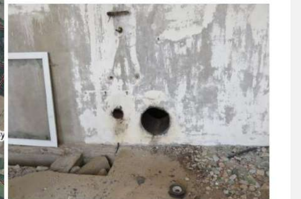
Název: IMG_1007_500x375.jpg Popis: Vyrovnávací stanice cítovské závlahové soustavy - severně nad Cítovem, nedaleko závlahové nádrže.
